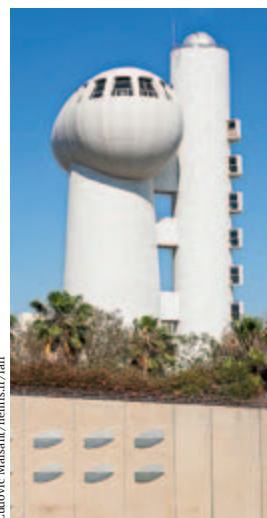
Wahrzeichen des Weizmann-Instituts ist der 1976 errichtete, heute nicht mehr in Betrieb befindliche Koffler-Teilchenbeschleuniger mit angebautem Observatorium.
